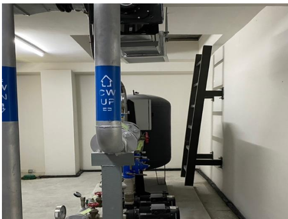
รูปที่ 17 ระบบปั้มน้ำดาดฟ้า
