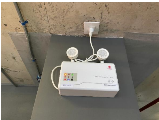
รูปที่ 34 ไฟฟ้าฉุกเฉิน
